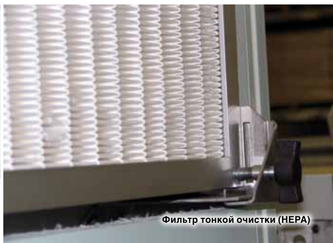
Карманный фильтр, закрепленный при помощи прижимной планки
